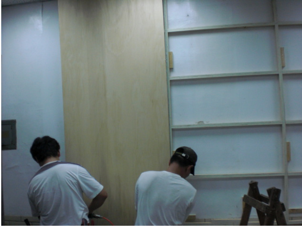
圖 7-3 壁板以釘槍及樹脂固定於骨架
