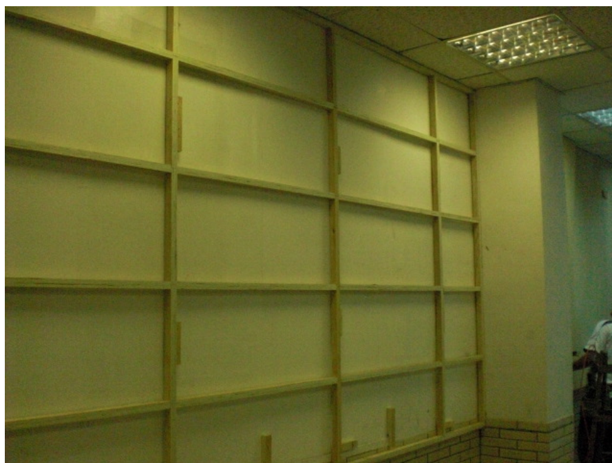
圖 7-2 壁板骨架設置
