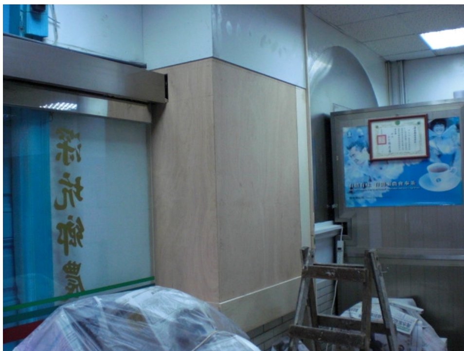
圖 7-6 服務台牆面壁板固定
